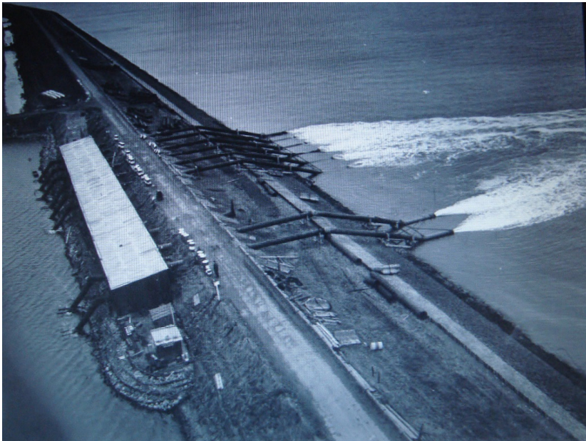
De pompen die het water bij Burghsluis terugpompten in de Oosterschelde
