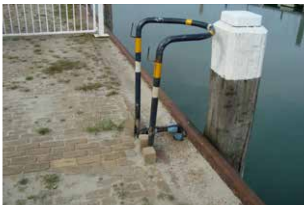
De drukleiding komt vanuit de haven en wordt aangesloten op de oude leiding.
