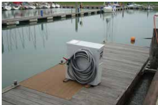
Dit is de nieuwe pomp op het steigerdeel, wel de achterkant, met afzuigslang.
